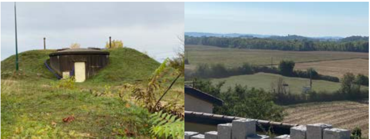
Réservoir de Montmert et captage du Pollet (depuis le hameau) [source : CE]
